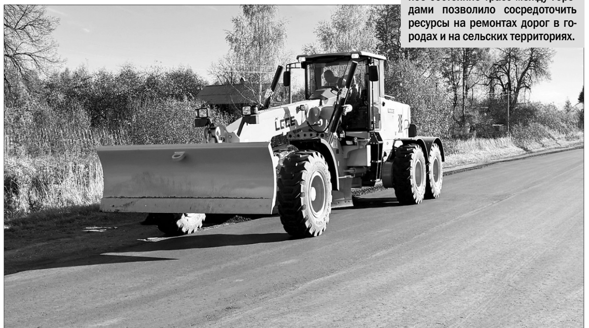
Подъезд к Лежневу через Курилиху только что отремонтирован.
