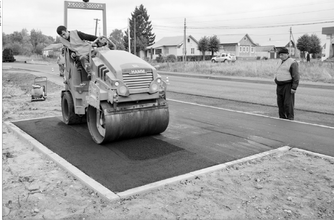
После ремонта появляются тротуары и остановки.
