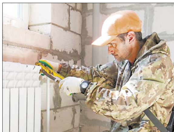
По мере окончания основных работ за дело берутся сантехники, электрики, отделочники...
