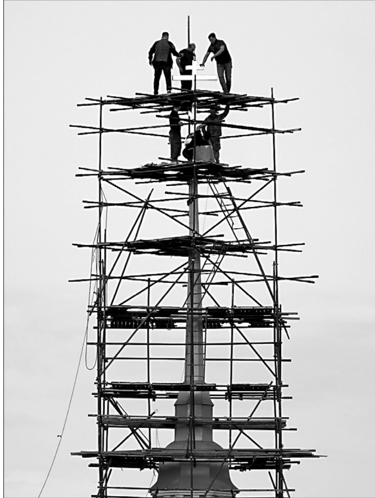
В 2026 году шпиль увенчал крест, похожий на тот, что был на колокольне в дореволюционные времена.
