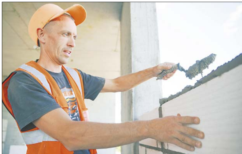
Наружные и внутриквартирные стены выкладываются из газоблоков.
