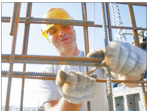
На 13-м этаже бригада монолитчиков занята сборкой железобетонных конструкций.
