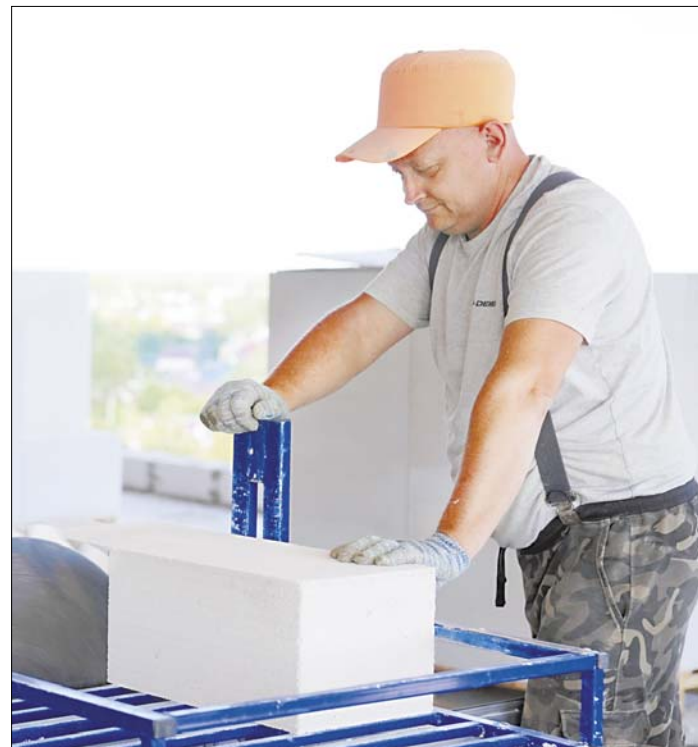
Плюсы этого материала – хорошая теплоизоляция, легкость в обработке. Минусы – хрупкость: без защиты фасада он сильно впитывает влагу.
