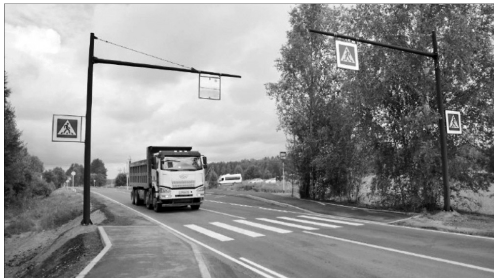
При ремонте дороги Иваново – Иванково использовали современные технологии.
