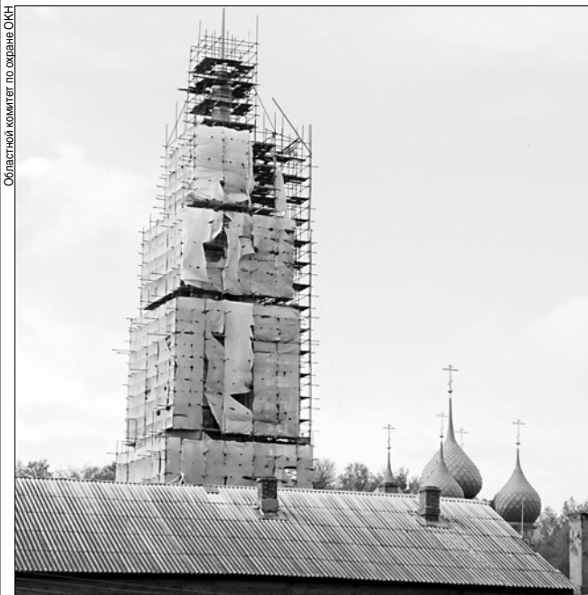
Колокольню в Юрьевце комплексно отреставрируют.
