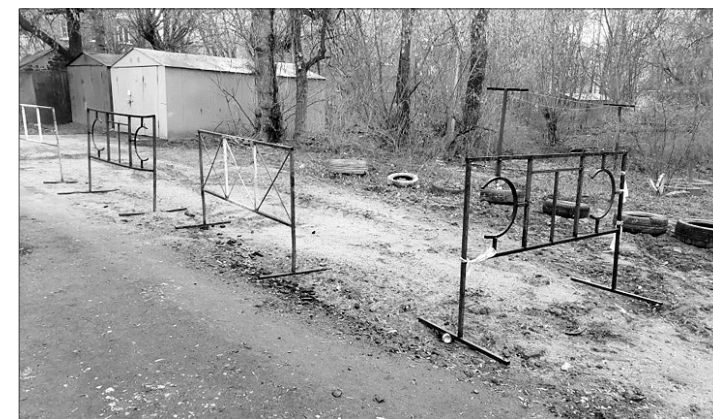
В апреле специалисты ИвГТЭ оградил территорию, откопали шины и подсыпали песка на место просадки грунта.
