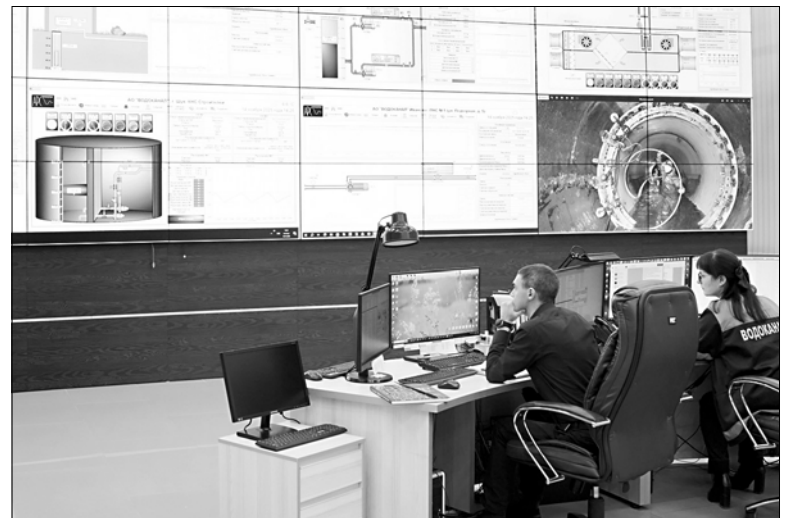
С помощью автоматизированного центра управления специалисты удаленно выявляют неполадки на сетях.
