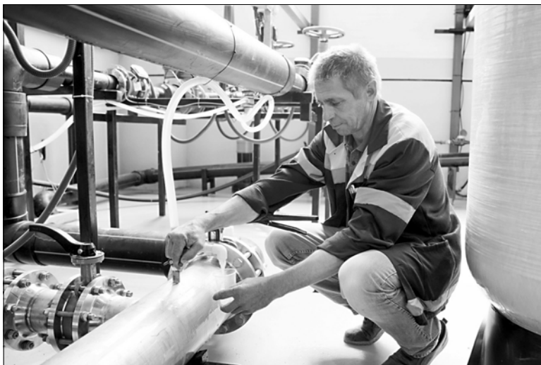
Летом станция обезжелезивания заработала в Гавриловом Посаде — благодаря ей жители теперь пьют чистую воду.
