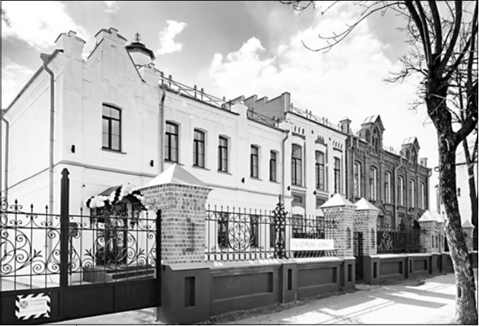
Долгие годы это здание на улице Ермака пустовало и разрушалось.
