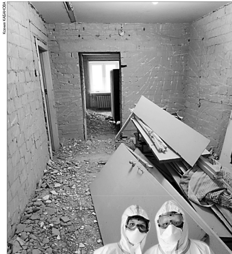
Так страшно всё выглядело в процессе демонтажа.
