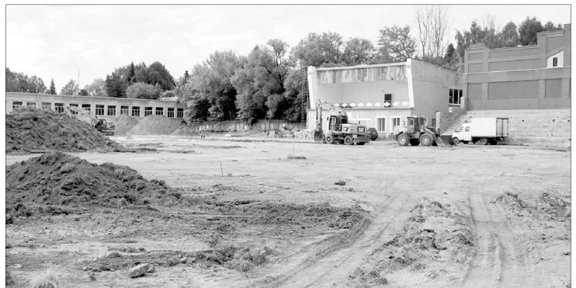
Темп строительства соответствует графику.
