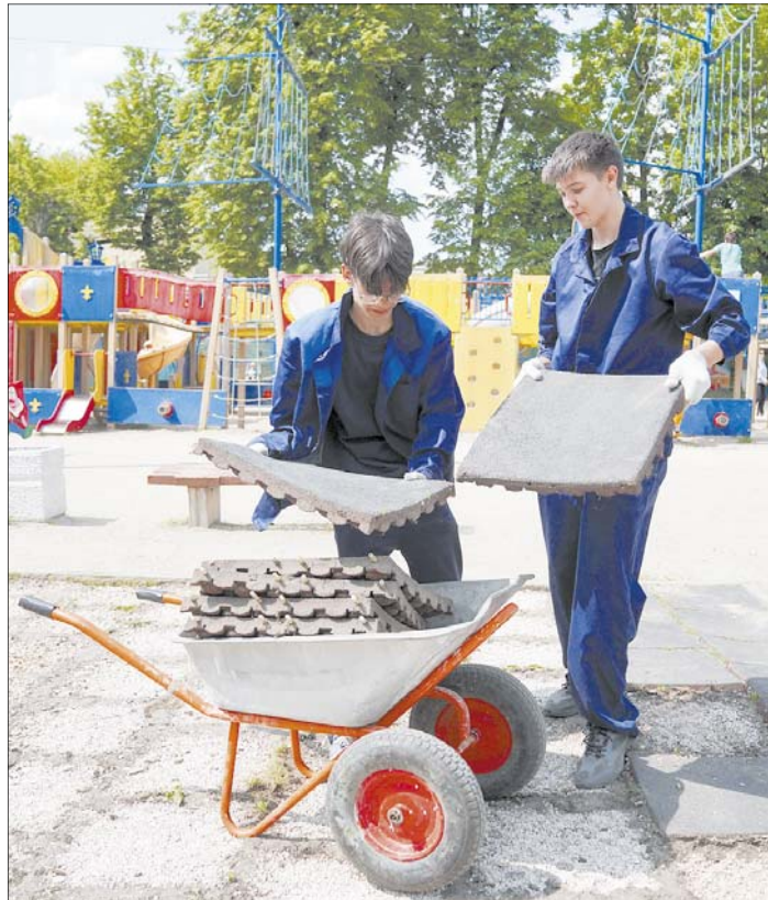
Молодежь удалила старое покрытие площадки.
