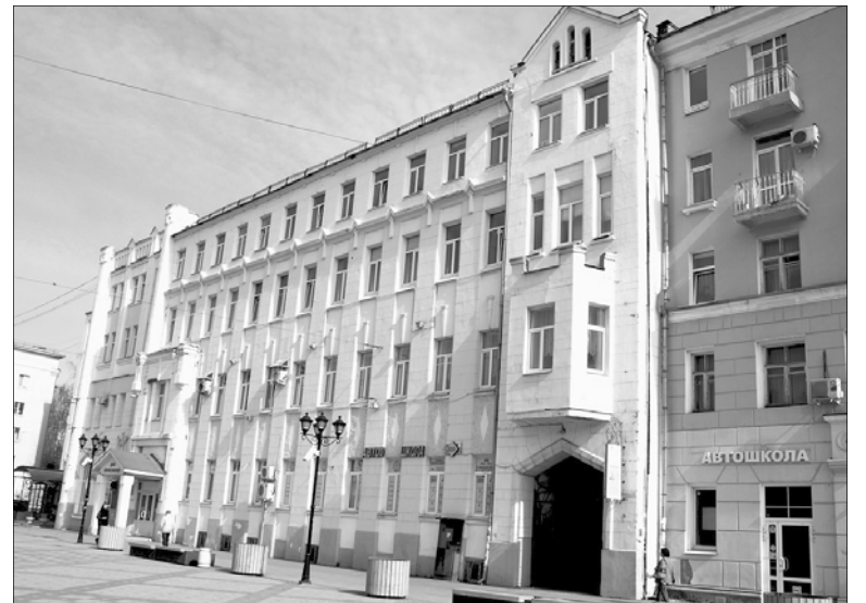
В этом здании на площади Ленина находилась первая студия радиовещания. Комната была на втором этаже в выступающей части фасада, над аркой.
