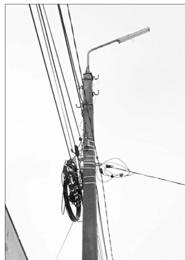
Незаконные провода несут угрозу надежности электроснабжения.
