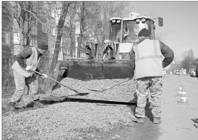
На Маршала Василевского в областном центре работы уже идут.
