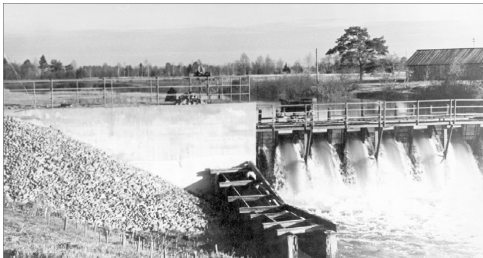
Каскад ГЭС на Нерли (1950-е годы).
