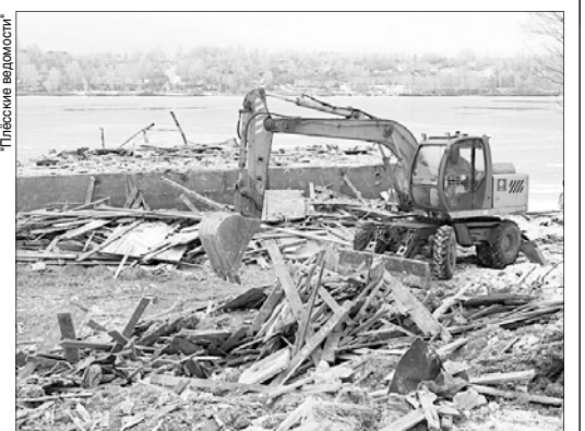
Специалисты заканчивают демонтаж затонувшего дебаркадера.
