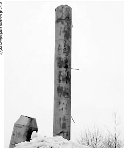
У водонапорной башни в Холуе отвалилась верхняя часть.
