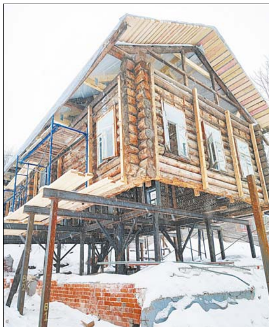
Дом купца Кузнецова до и после противоаварийных работ.
