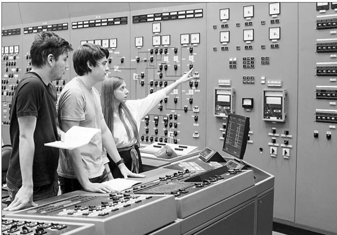
Тренажер энергоблока Калининской АЭС позволяет воссоздать условия работы персонала атомной станции, в том числе в условиях аварии.
