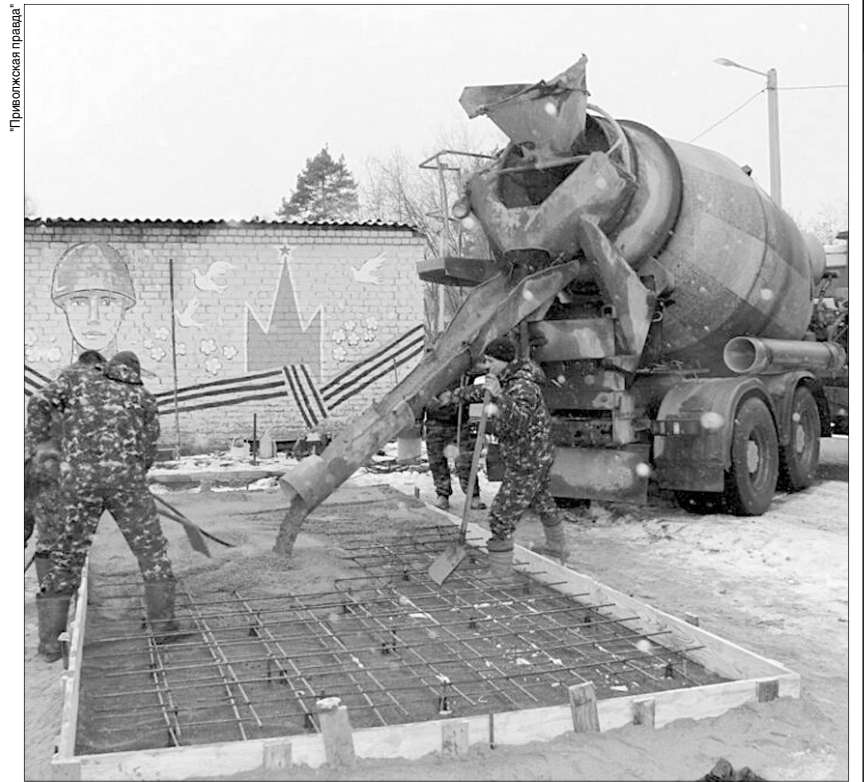
Подрядная организация бетонирует площадку под зенитно-ракетный комплекс "Куб".
