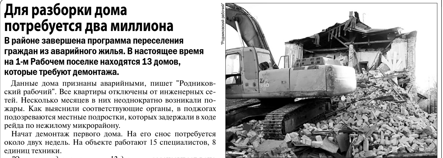
В Родниках начал демонтаж первого дома на Рабочем поселке.
