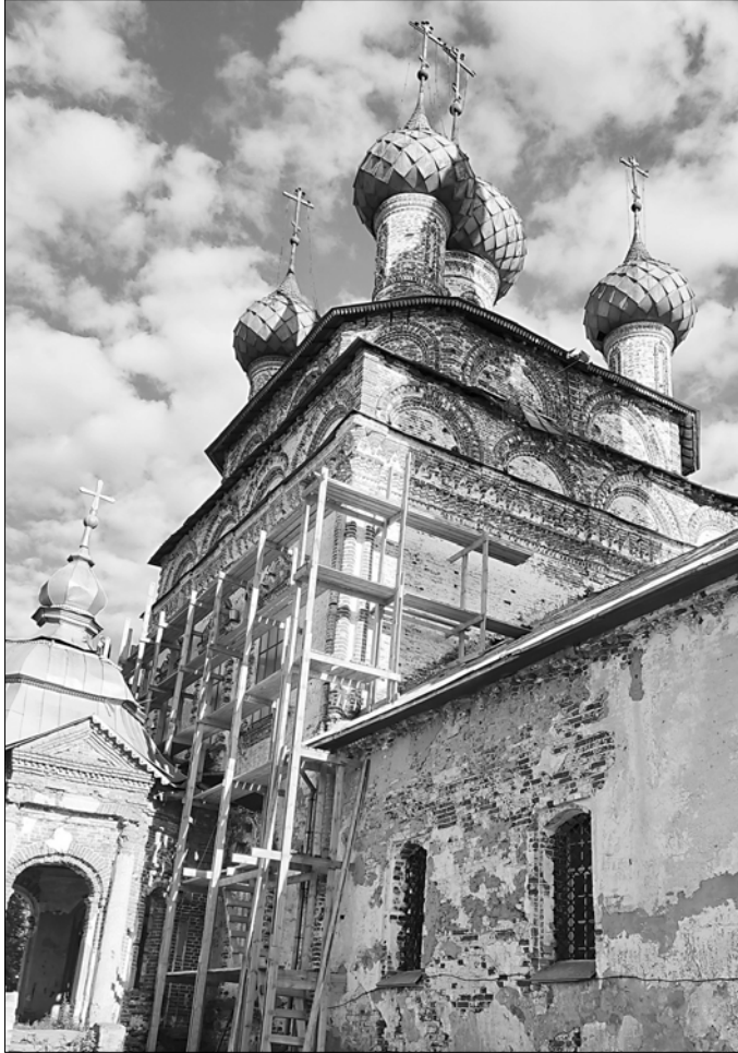
В 2025 году церковь должны подготовить к реставрации.
