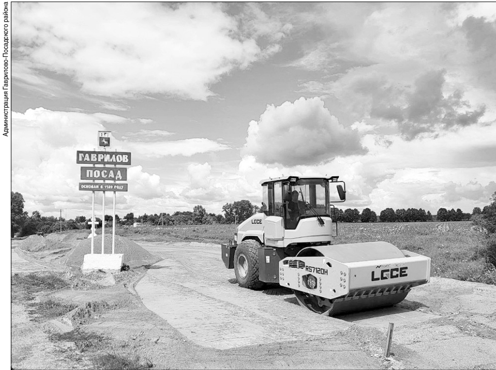
Ремонт дороги, связывающий два исторических центра, Гаврилов Посад и Суздаль.
