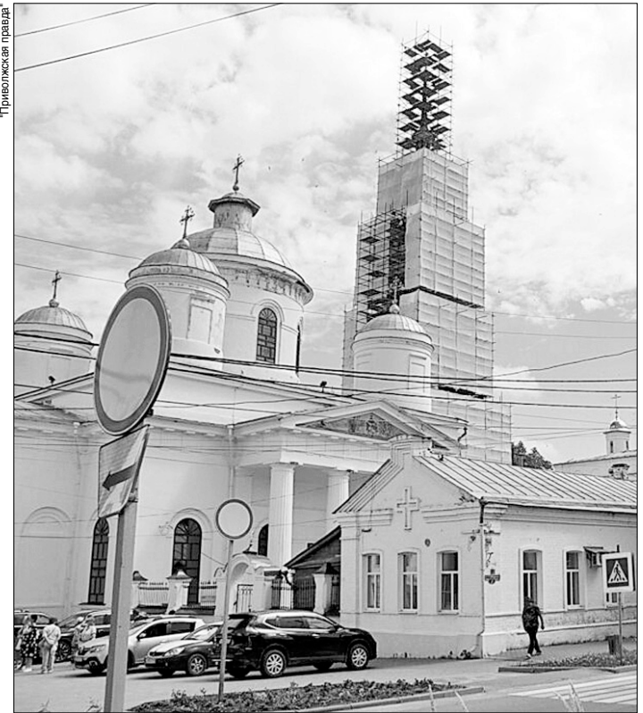
Строители отреставрируют фасады, воссоздадут столярные заполнения дверных проемов, большой и малый купола и шпиль.
