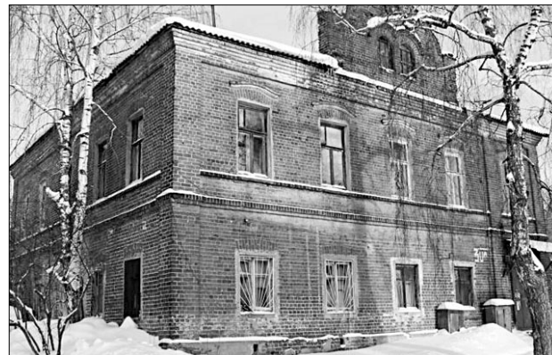
У памятника архитектуры местного значения отремонтируют фундамент, стены, перекрытия, инженерные коммуникации.
