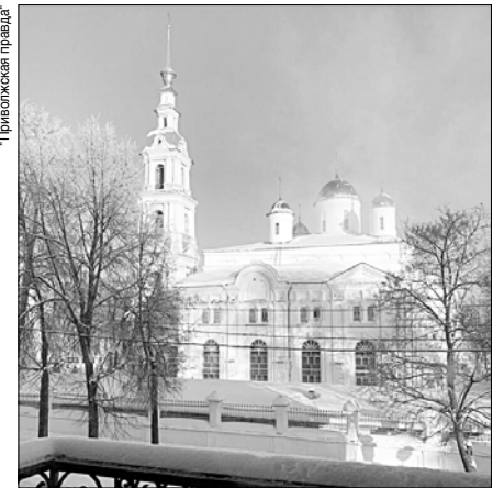
Колокольня дождалась большого ремонта.
