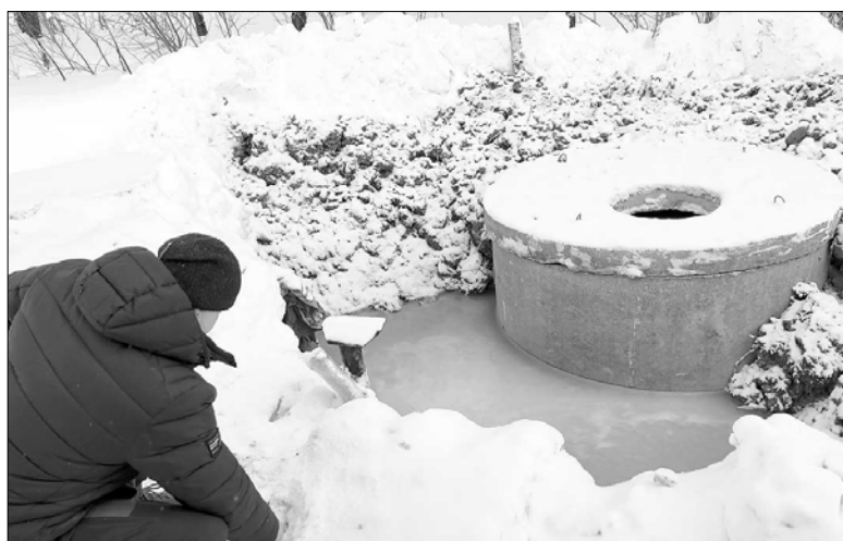
В Родниках смонтированы и почищены еще три скважины.
