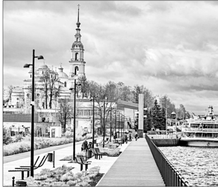
На прилегающей к Волге территории появятся пешеходные дорожки, освещение и озеленение.
