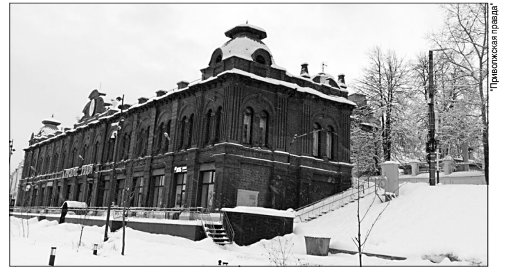
Суд обязал администрацию отремонтировать лестницу-спуск к Молодежному скверу.
