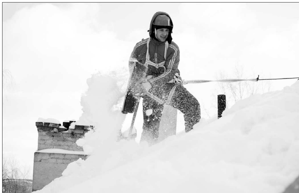
Немало жалоб в жилищную инспекцию поступает на состояние крыши.
