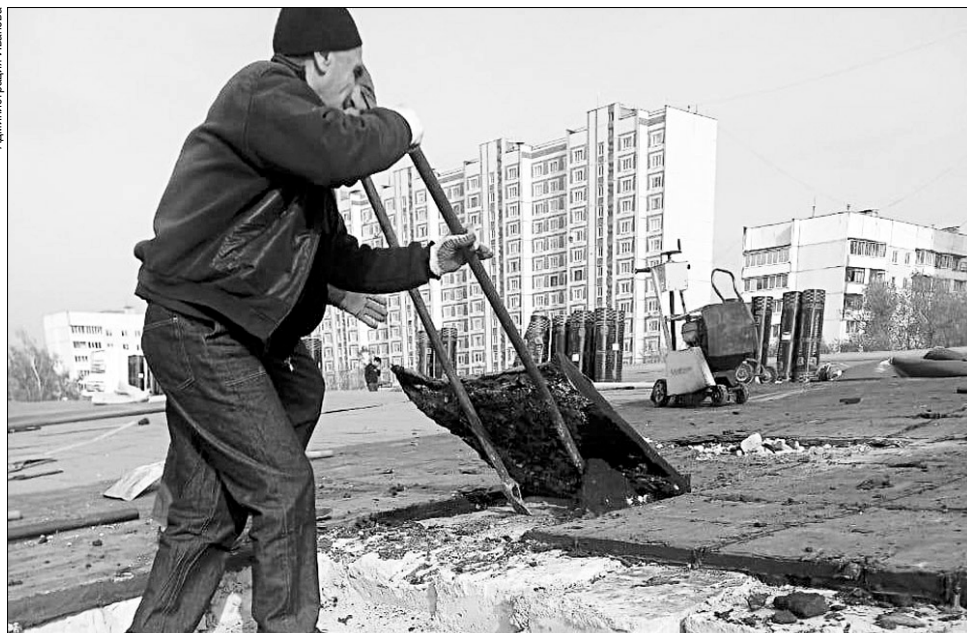
Старую кровлю строители сравнивают с лоскутным одеялом.
