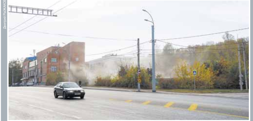
Общежитие студенческого городка Ивановского политехнического института. Здание возвели в 1931 году, а осенью 2023-го снесли.
