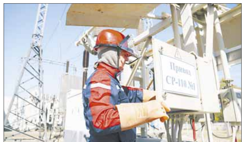
В регионе – 144 электрические подстанции, которые расположены во всех районных центрах.
