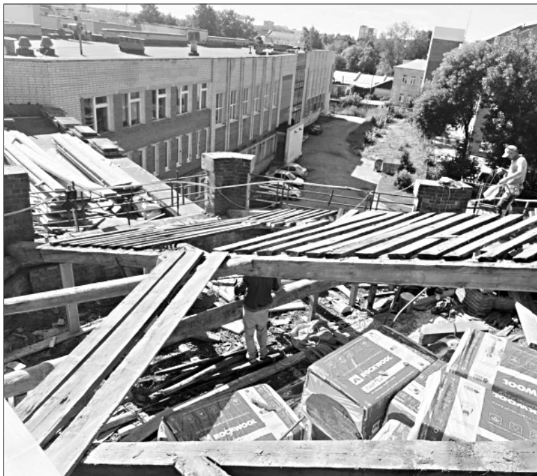
Ремонт обсерватории начали с кровли.
