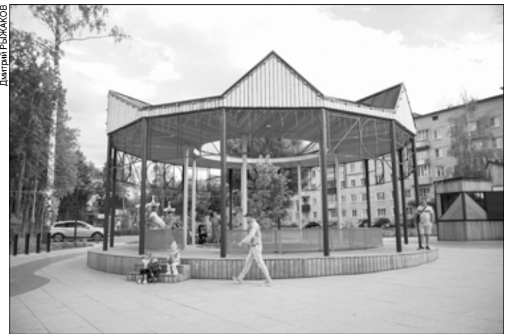
Ранее в Фурманове после победы во всероссийском конкурсе отремонтировали "Новый торг".
