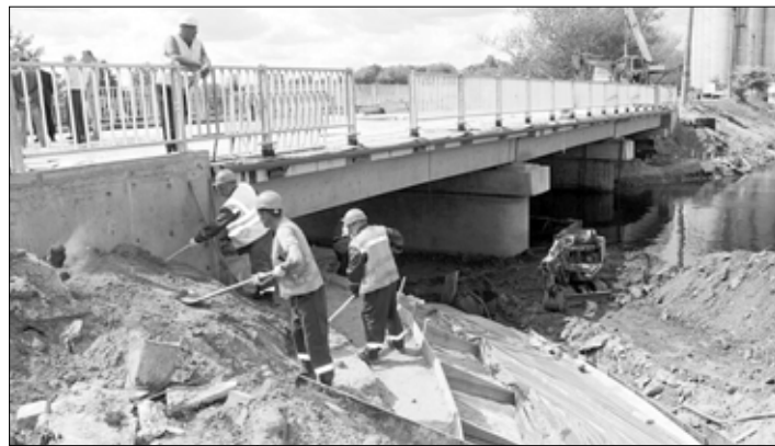
В Кинешме идут ремонты мостов через Казоху и Томну.
