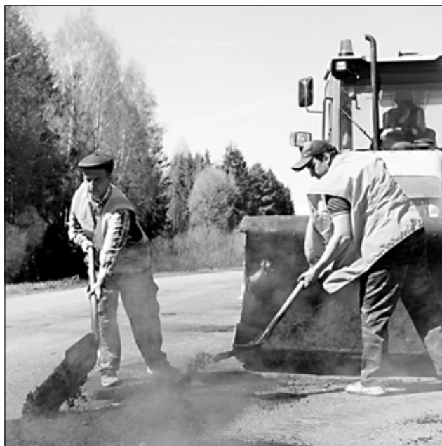
За пять лет отремонтировали 1682 километра дорог.
