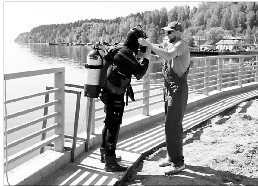
С помощью водолазов нарушение герметичности шва шпунтового ряда на Юрьевецкой дамбе полностью ликвидировано.
