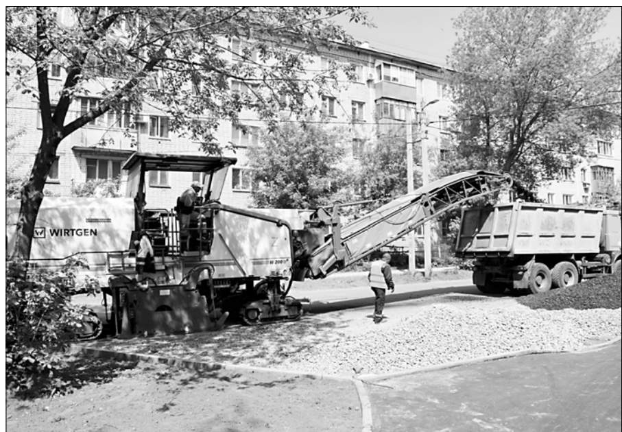
В масштабном ремонте проезжей части и тротуаров широко задействована техника.
