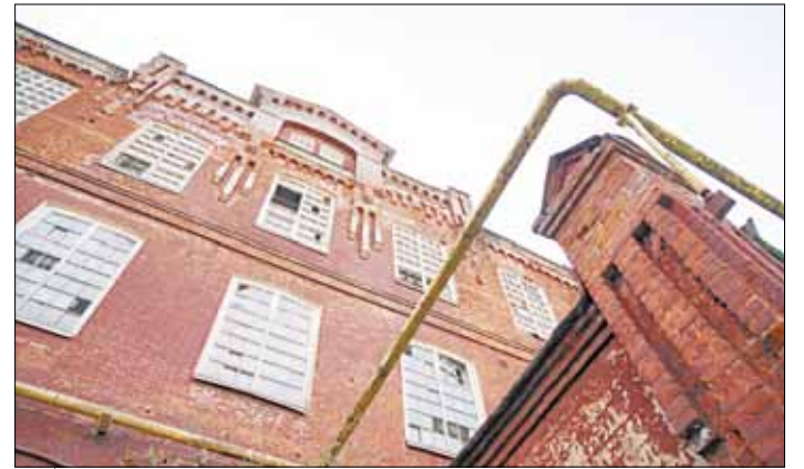
Изначально корпуса мануфактур были без декора. Лишь позднее стали украшать внешний вид зданий. Поэтому только верхние этажи имеют отделку.
