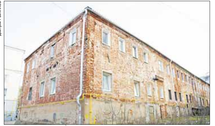
Пример набивного корпуса мануфактуры Ямановского. Здание лишилось третьего этажа и стало жилым домом.
