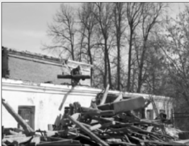
В писцовском Доме культуры демонтировали крышу.
