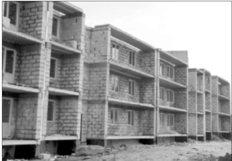
На первом этапе завершено строительство коробки дома в микрорайоне имени Шагова.
