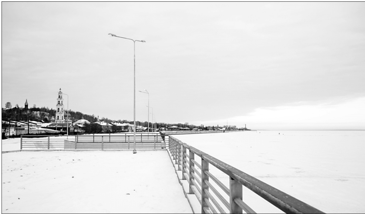
В этом году дамбу в Юрьевце официально запустят в эксплуатацию после ремонта.
