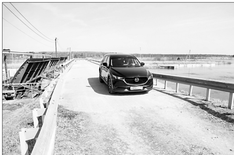
Гидроузел в Холуе на время строительства моста становится и переправой.
