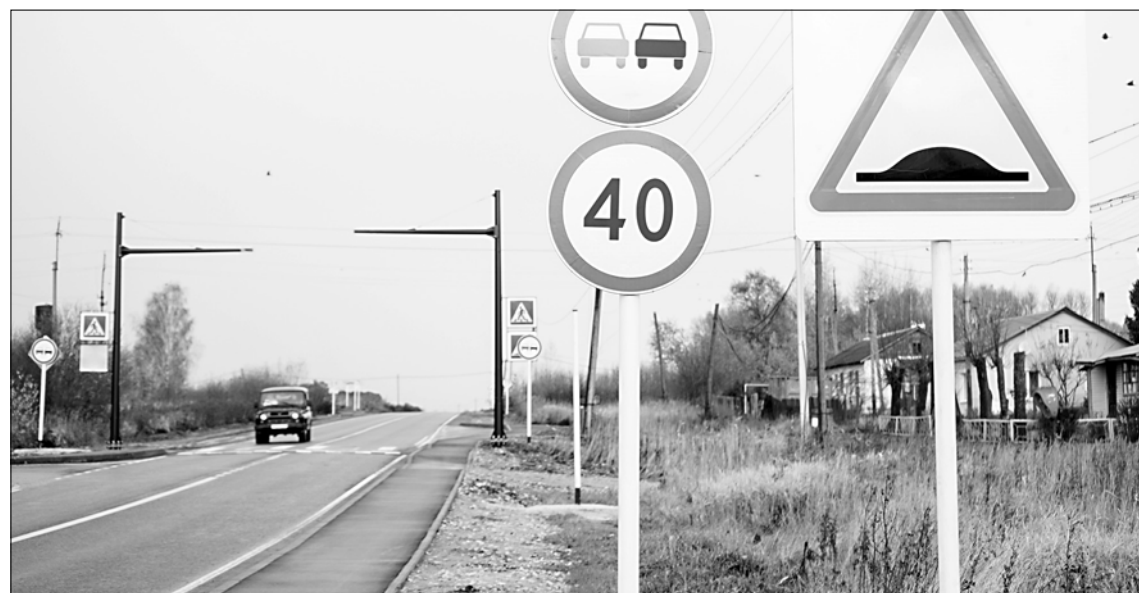
Ремонт дорог проходит комплексно: рабочие ставят новые знаки, наносят разметку, обустривают тротуары и освещение.
