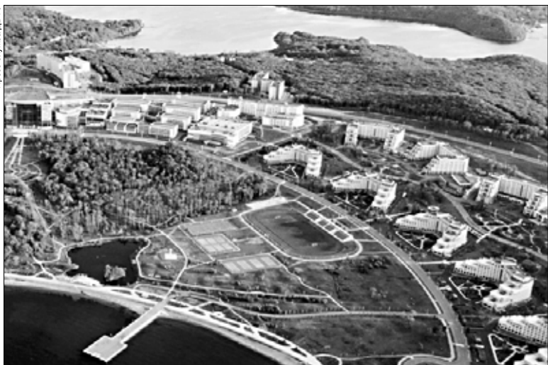
Дальневосточный федеральный университет во Владивостоке.
