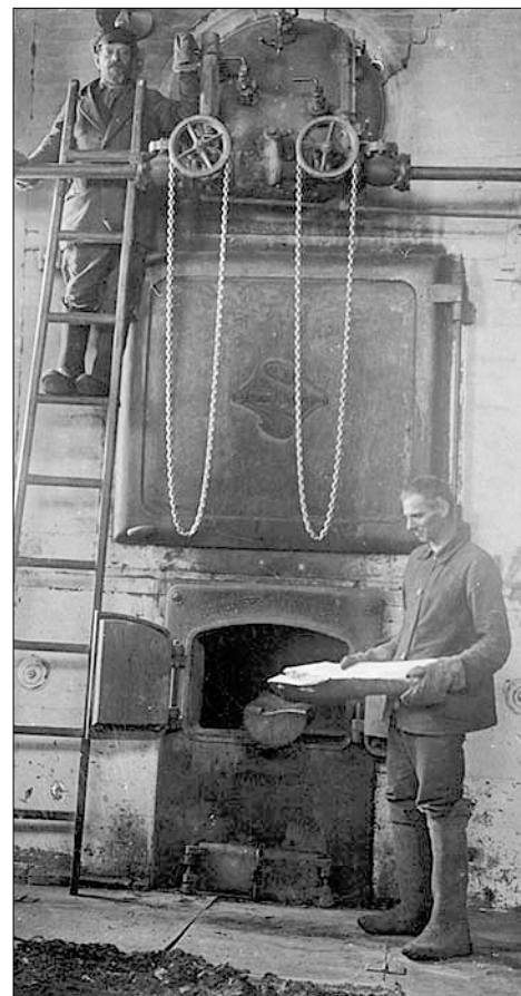
Котел на лесокомбинате в Васильевском до сих пор в рабочем состоянии.
