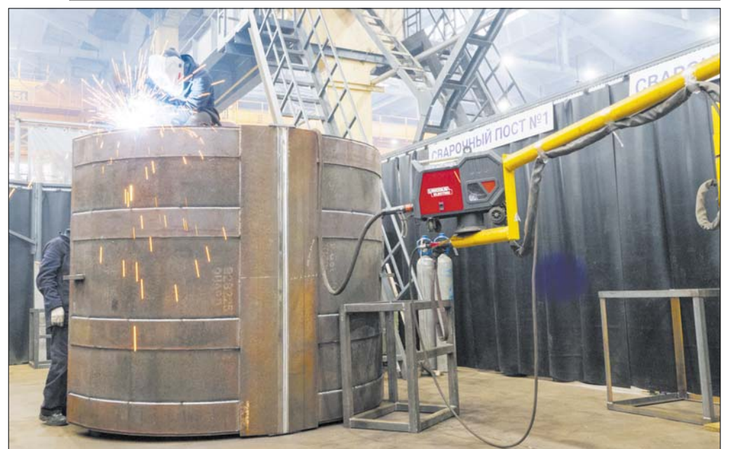
Для сварки некоторых изделий требуется лестница.
