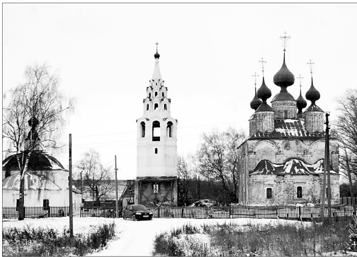
Древняя колокольня в Сербилове находится в плачевном состоянии.
