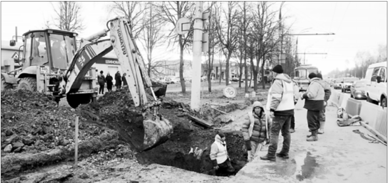
70% работ уже выполнено.
