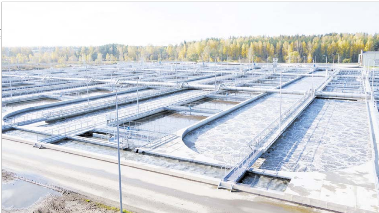
Активный ил перерабатывает органические вещества, тем самым обеспечивая биологическую очистку.
