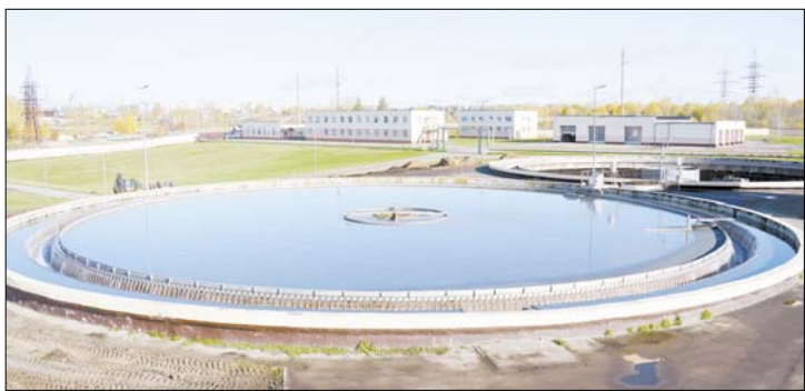
Для удаления мусора средней величины используют первичные отстойники. Вместимость одного резервуара – 4,5 тыс. кубометров.
