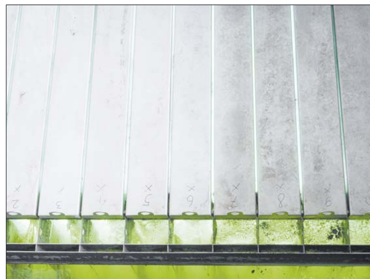
Использование микрофильтров и ультрафиолетовое обеззараживание – заключительный этап, после которого уже чистая вода попадает в Уводь.
