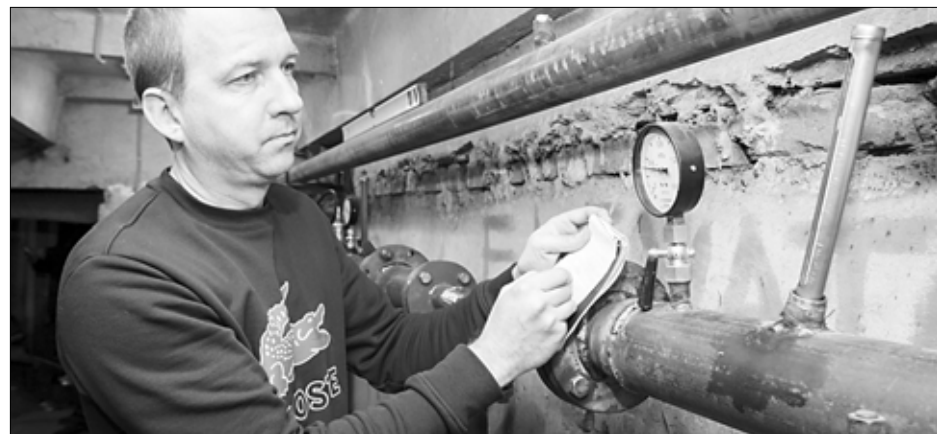
Тепловики уверяют, что дозвониться до них сложнее не стало.
