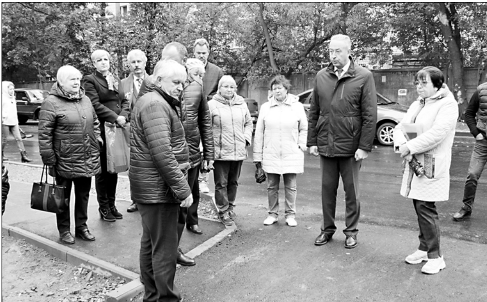
По просьбе жильцов строители поднимут высоту асфальтобетонного покрытия, чтобы не подтапливались дворы.
