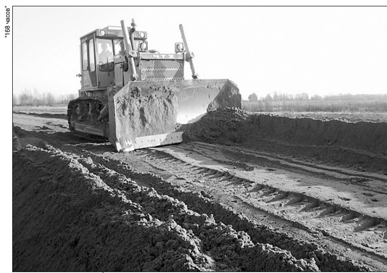
Бульдозеры завершили свою работу на участке Жажлево – Норское.
