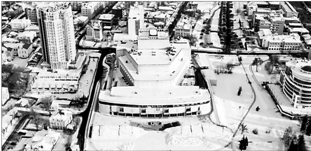
В Ивановском театральном комплексе отремонтируют крышу.
