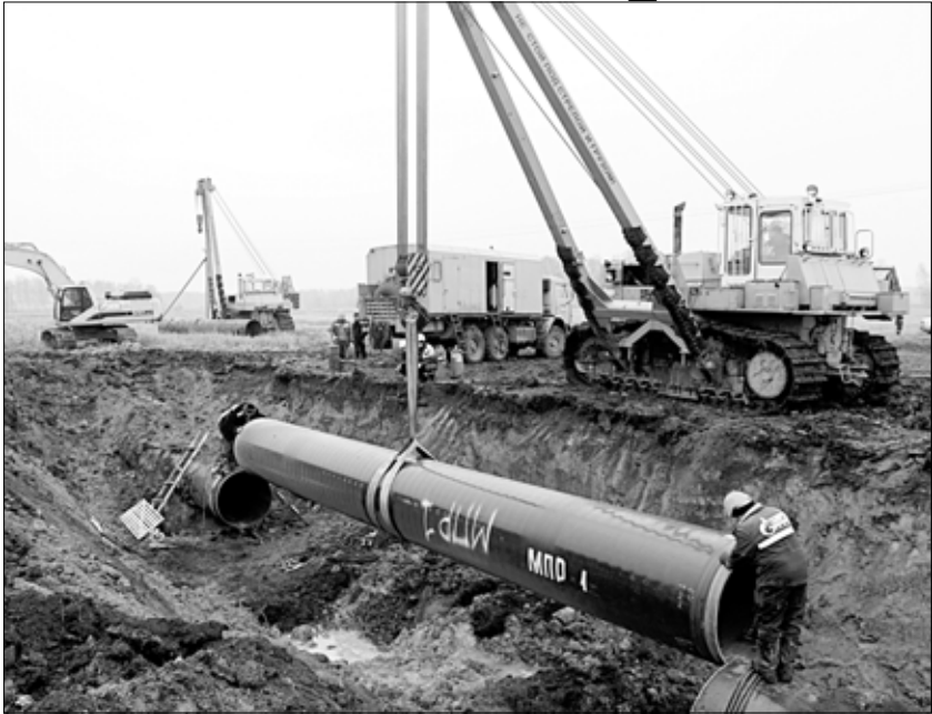
Идет прокладка межпоселкового газопровода в Гаврилово-Посадском районе.
