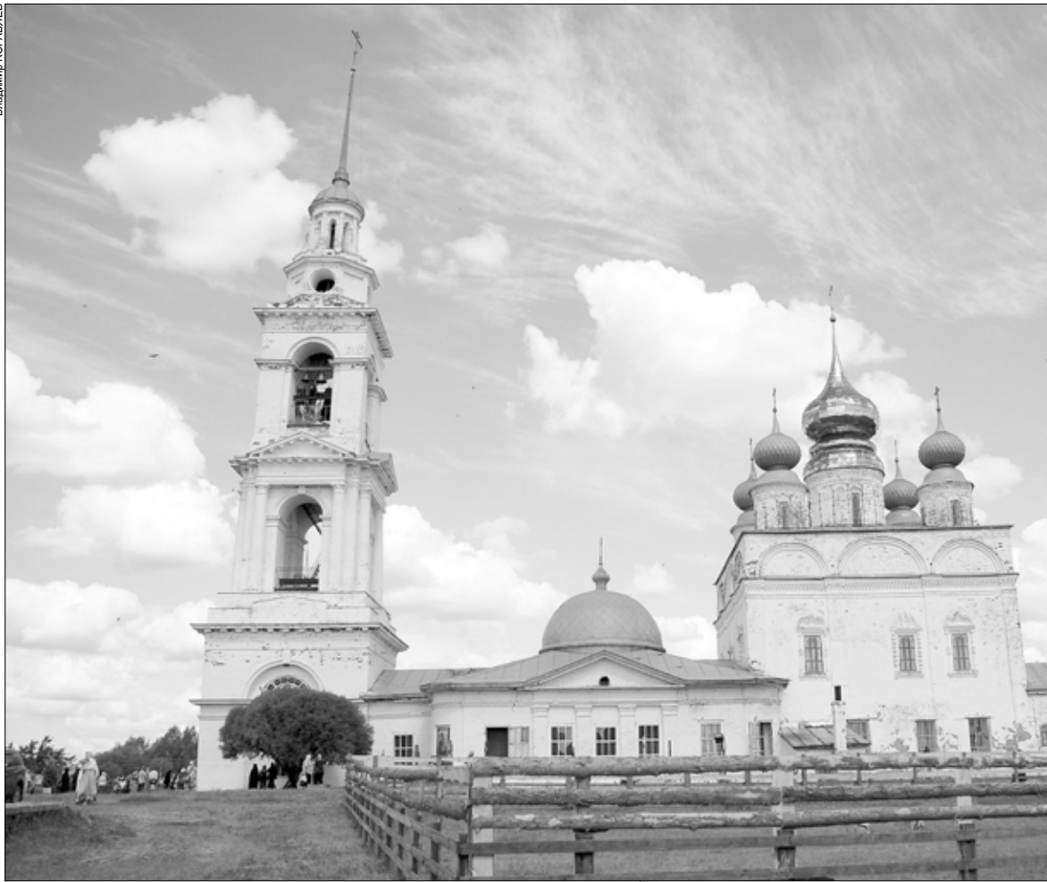
В советские годы в церкви ремонтировали трактора.
